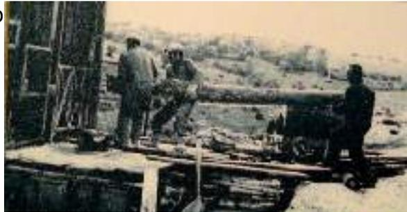
vvero il personale addetto al servizio di estrazione, che mediante le "gabbie" e gli "argani", trasferisce all'esterno i vagoni carichi di minerale, o rifornisce il sotteraneo di legname e di quanto altro necessita.
